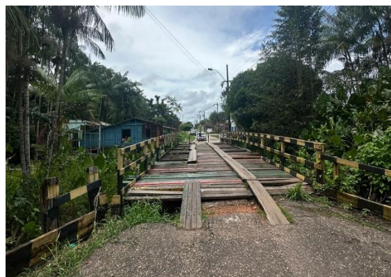
Figura 02 – Estrutura atual da ponte em madeira, apresentando desgaste e comprometimento do tabuleiro.
