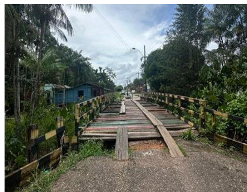
Figura 06 – Estrutura atual da ponte em madeira, apresentando desgaste e comprometimento do tabuleiro.
