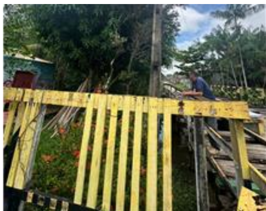
Figura 03 – Estrutura atual da ponte em madeira, apresentando desgaste e comprometimento do tabuleiro.
