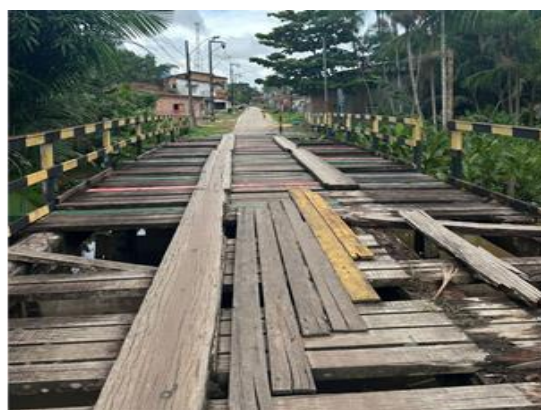
Figura 04 – Estrutura atual da ponte em madeira, apresentando desgaste e comprometimento do tabuleiro.
