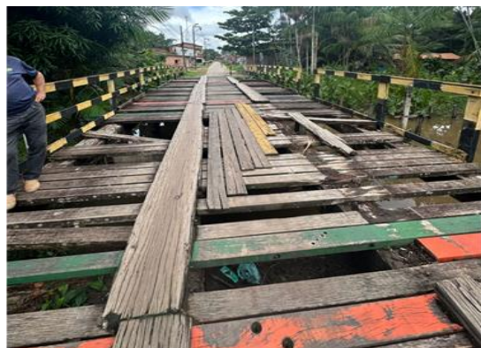
Figura 05 – Estrutura atual da ponte em madeira, apresentando desgaste e comprometimento do tabuleiro.
